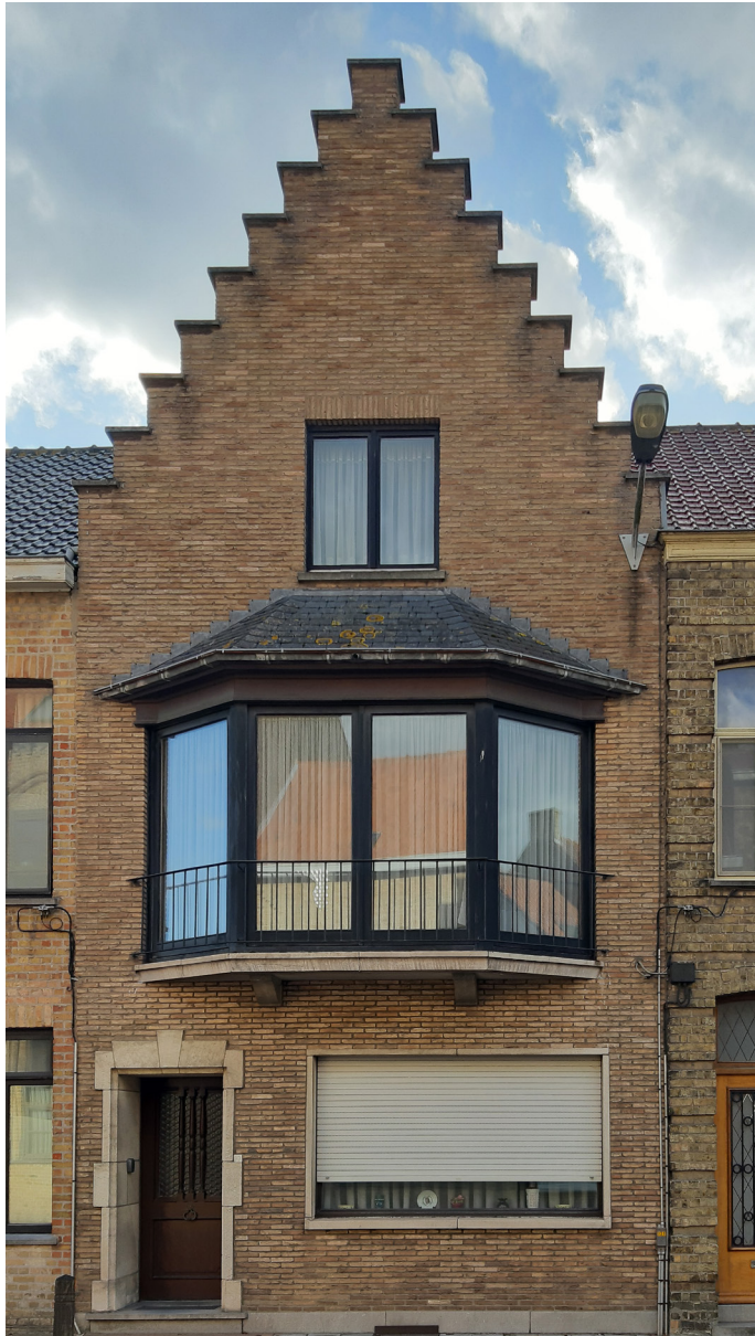
Oude Vestingstraat 77 . bestaande toestand
