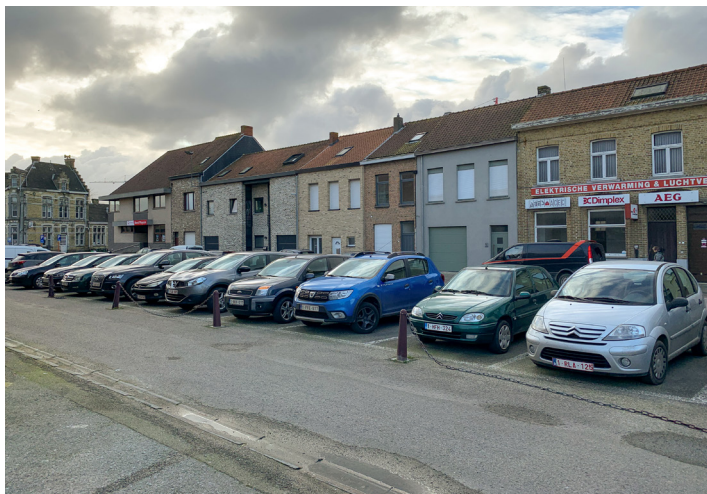
publieke ruimte en wegenis aan Statieplaats en Rodestraat
