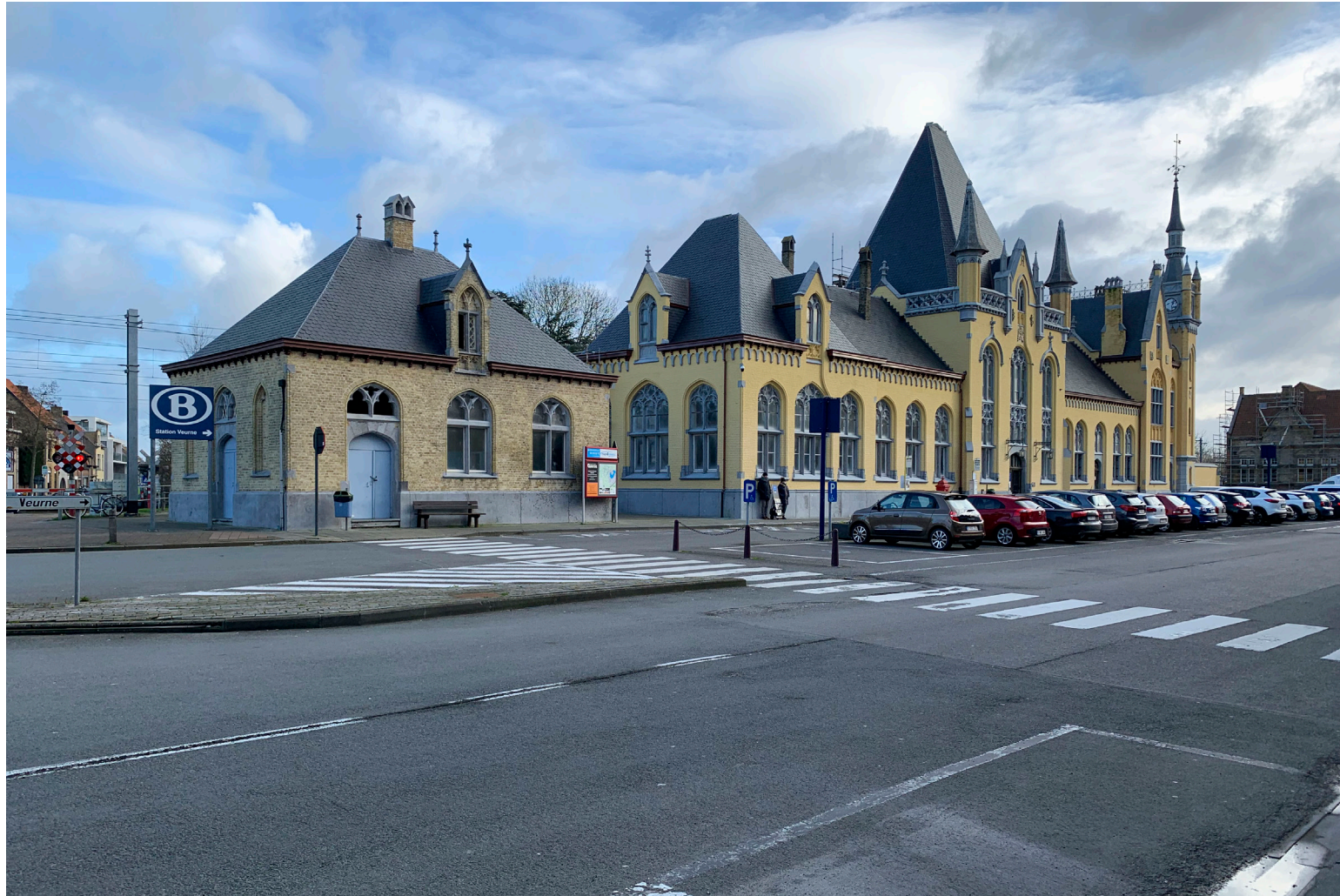
Figuur 35 station Veurne, Statieplaats
